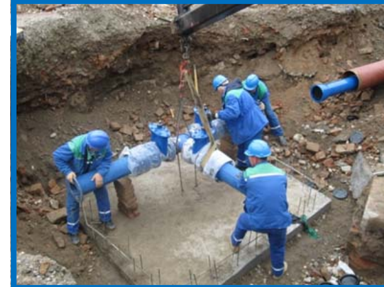
Montaža jaška - Mlinska ul.
