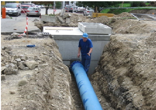
Montaža litoželezne cevi DN 400 in jaška pri rondoju na Titovi cesti.
