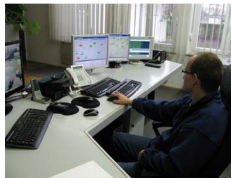
Center daljinskega vodenja in nadzora vodooskrbnih objektov vključenih v telemetrični radijski nadzorni sistem
