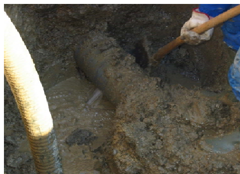
Popravilo cevovoda PVC dn 225 na liniji proti Kungoti
