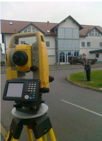
Izmera novozgrajenega hišnega vodovodnega jarka in zaklopnika
