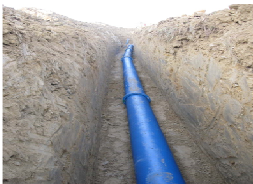
S tem cevovodom, ki je bil 30. novembra 2012 dokončno obnovljen od Počehove do Kungote, se bodo prihranile velike izgube vode. Zgrajen je iz kvalitetne litine, ki ustreza sedanjim standardom.
