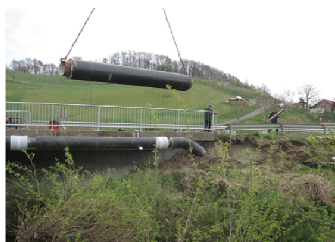
Novi cevovodi čez reko Pesnico. V sklopu severovzhodne Slovenije smo sodelovali pri zamenjavi dotrajanega azbestcementnega cevovoda premera 250 mm.
