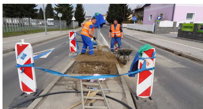
Popravilo cevi Cesta XIV. divizije 51, Maribor
