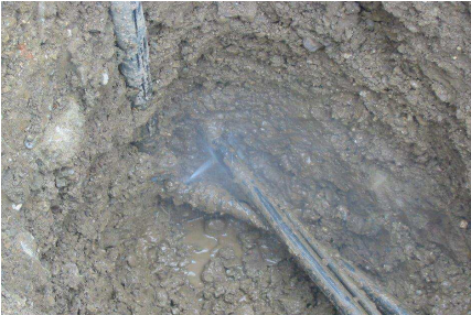
Najpogostejša napaka na hišnih priključkih je počena spojka
