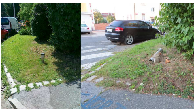
Levo: zgledno urejen Desno: uničeno ustje piezometra, najverjetneje s tovornjakom
