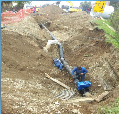
Varjenje in izvedba izolacije na cevi
