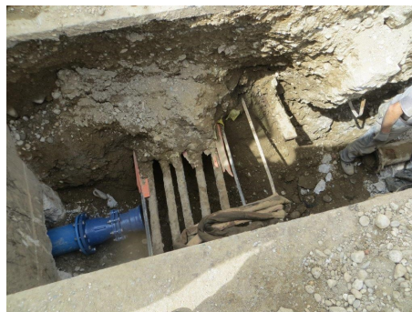
Pri zamenjavi priključka je treba paziti tudi na ostale komunalne priključke
