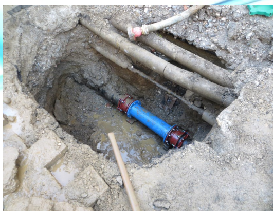
Popravilo z univerzalnimi spojkami in vgradnjo FF komada
