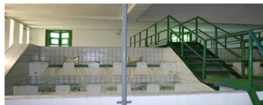
Bogatenje vode v Vodarni na Vrbanskem platoju
