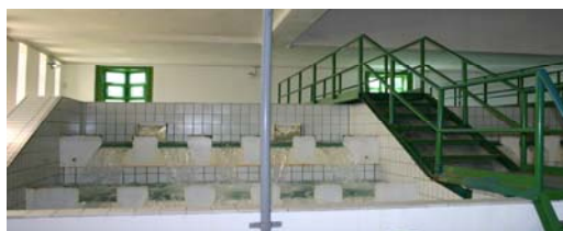
Bogatenje vode v Vodarni na Vrbanskem platoju
