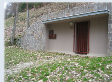
Prečrpalnica in vodohran BRESTERNIŠKA GRABA
