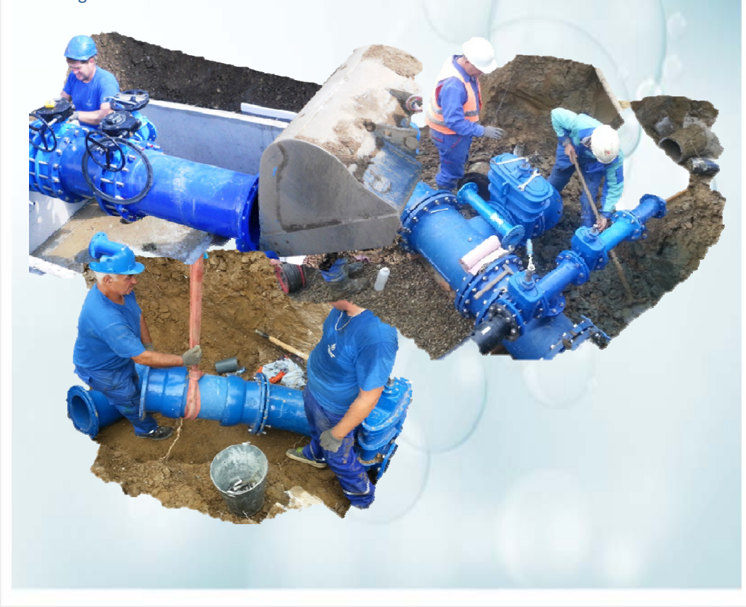
Utrinki iz gradbišč
